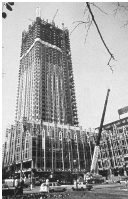
شکل ۳-۱ - عملیات ساختمانی یک مجتمع تجاری چند طبقه
